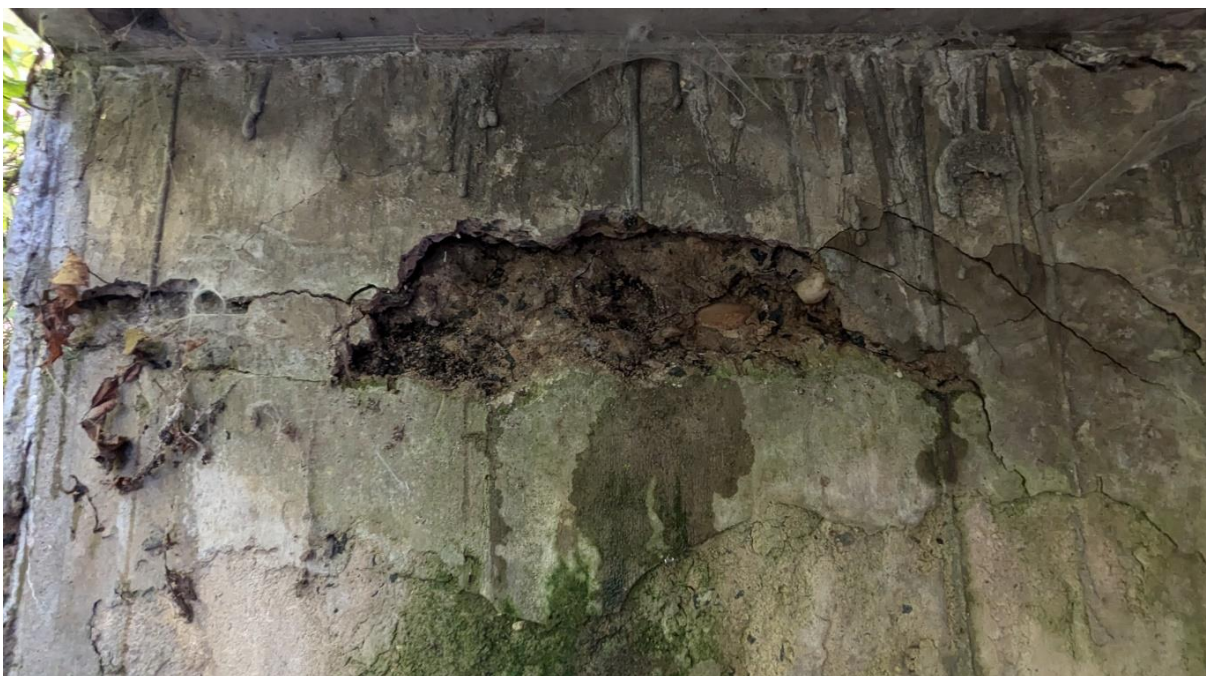
Obr. 17 Porucha izolace na rubu opěr
