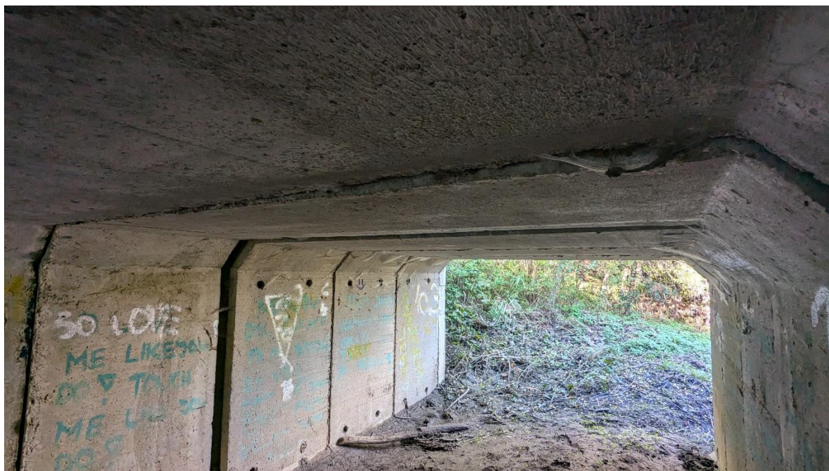
Obr. 7 Pohled na horní hranu nosné konstrukce, chybné uložení/ nerovnoměrné sedání prefabrikátů
