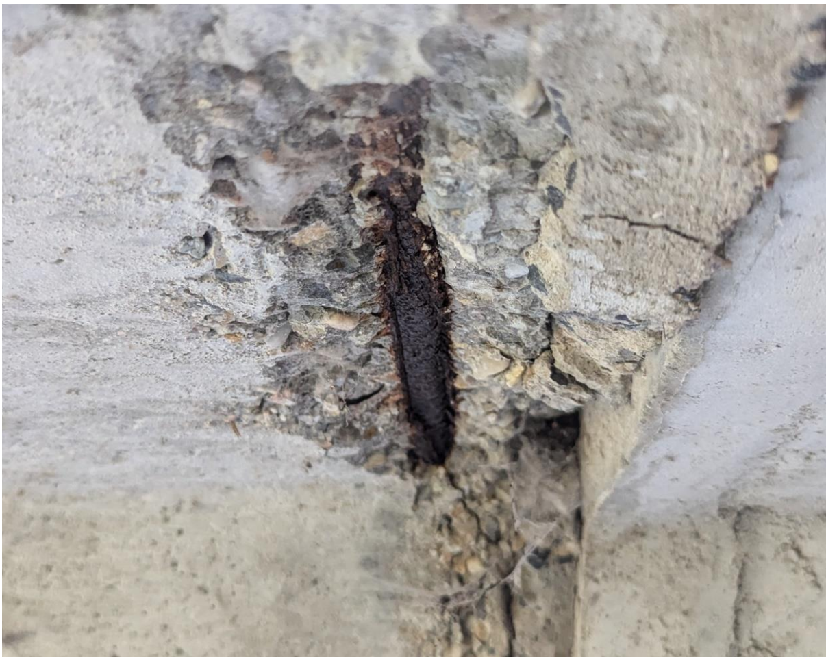
Obr. 14 Korodující obnažená výztuž, štěrkové hnízdo, nedostatečné krytí betonářské výztuže
