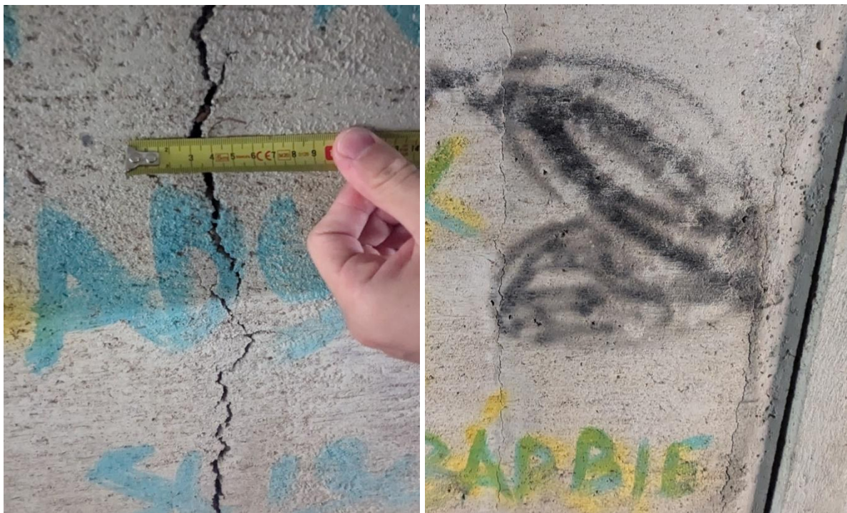
Obr. 10 Detail podélných trhlin
