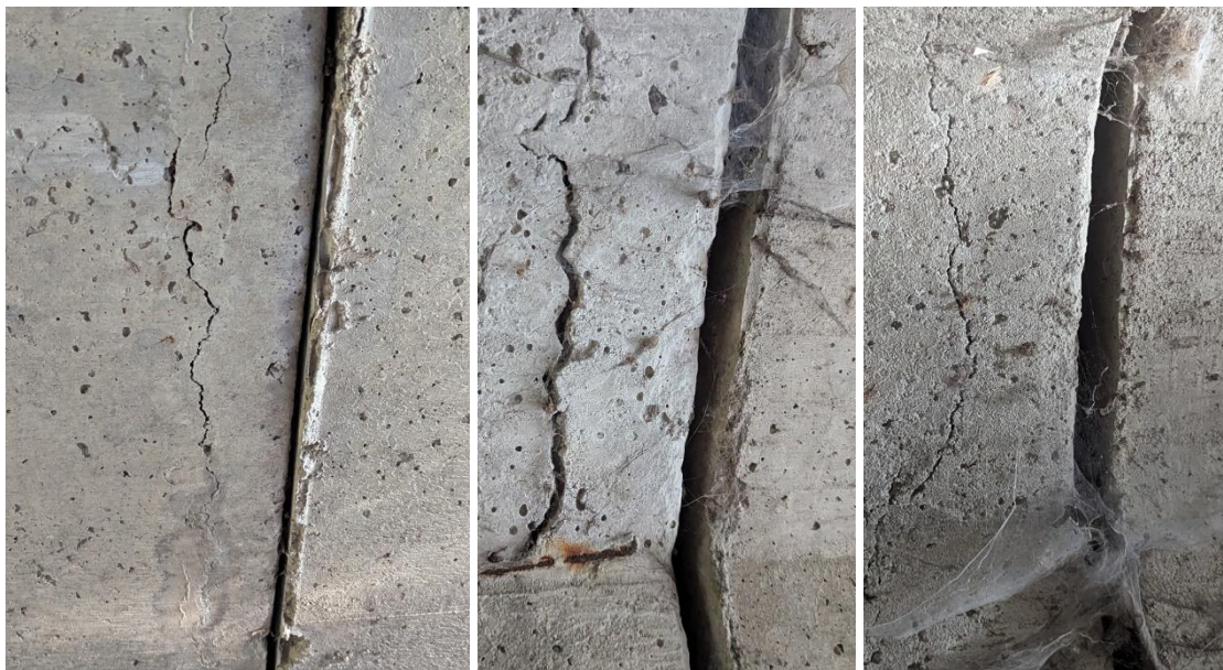
Obr. 12 Potrhané rohy prefabrikátů, nedostatečné krytí betonářské výztuže
