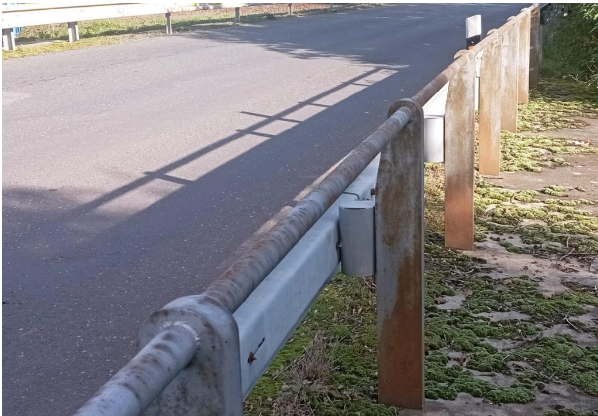
Obr. 27 Koroze svodidel
