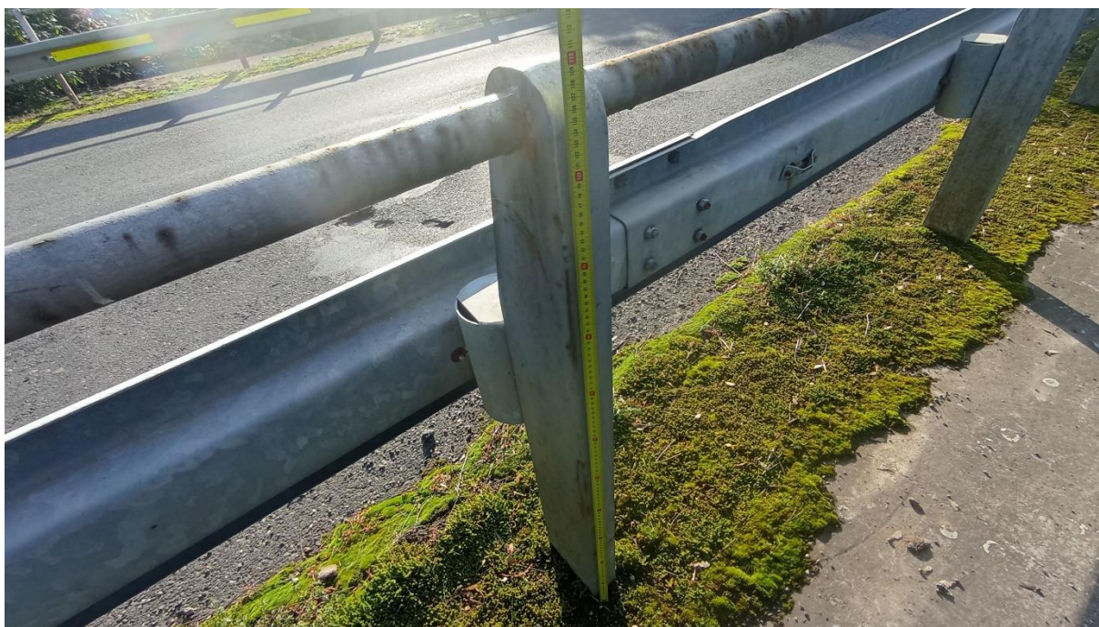
Obr. 27 Koroze svodidel
