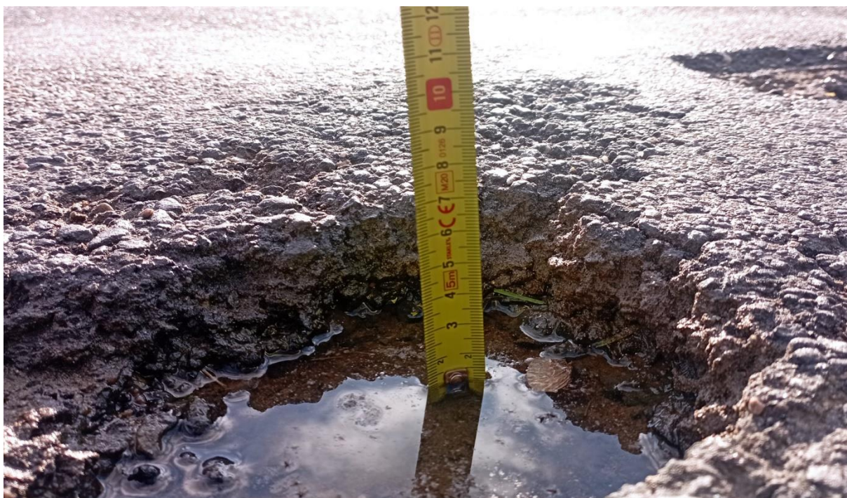
Obr. 26 Detail výtluku ve vozovce
