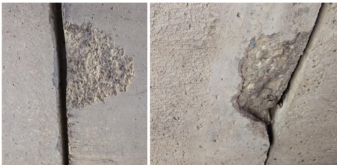
Obr. 13 Degradace betonu na rozích prefabrikátů – štěrková hnízda/nekázeň při montáži
