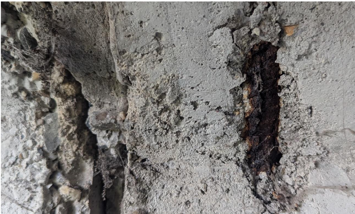
Obr. 15 Korodující obnažená výztuž, štěrkové hnízdo, nedostatečné krytí betonářské výztuže
