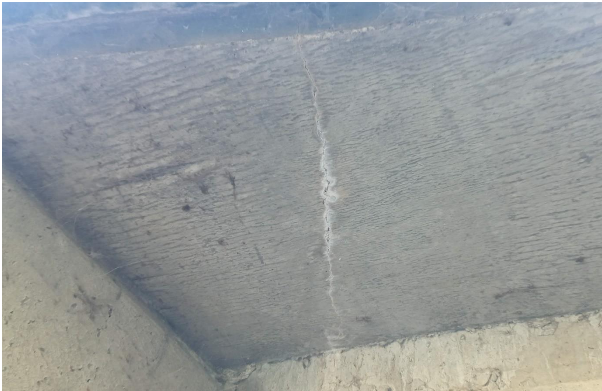
Obr. 18 Detail příčné trhliny s průsakem na levé římse
