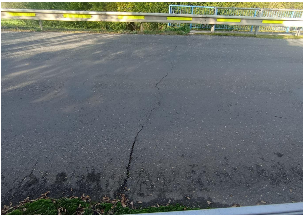
Obr. 24 Příčné trhliny v místě přechodových oblastí
