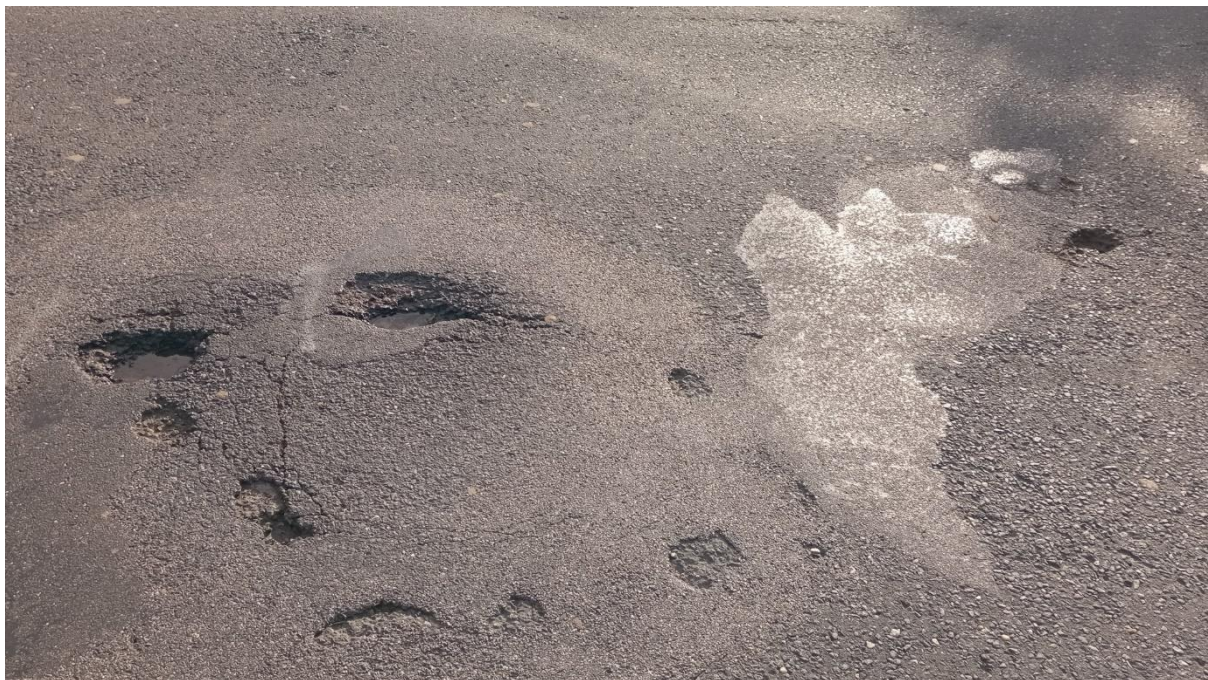
Obr. 25 Výtluky ve vozovce nad středovým polem
