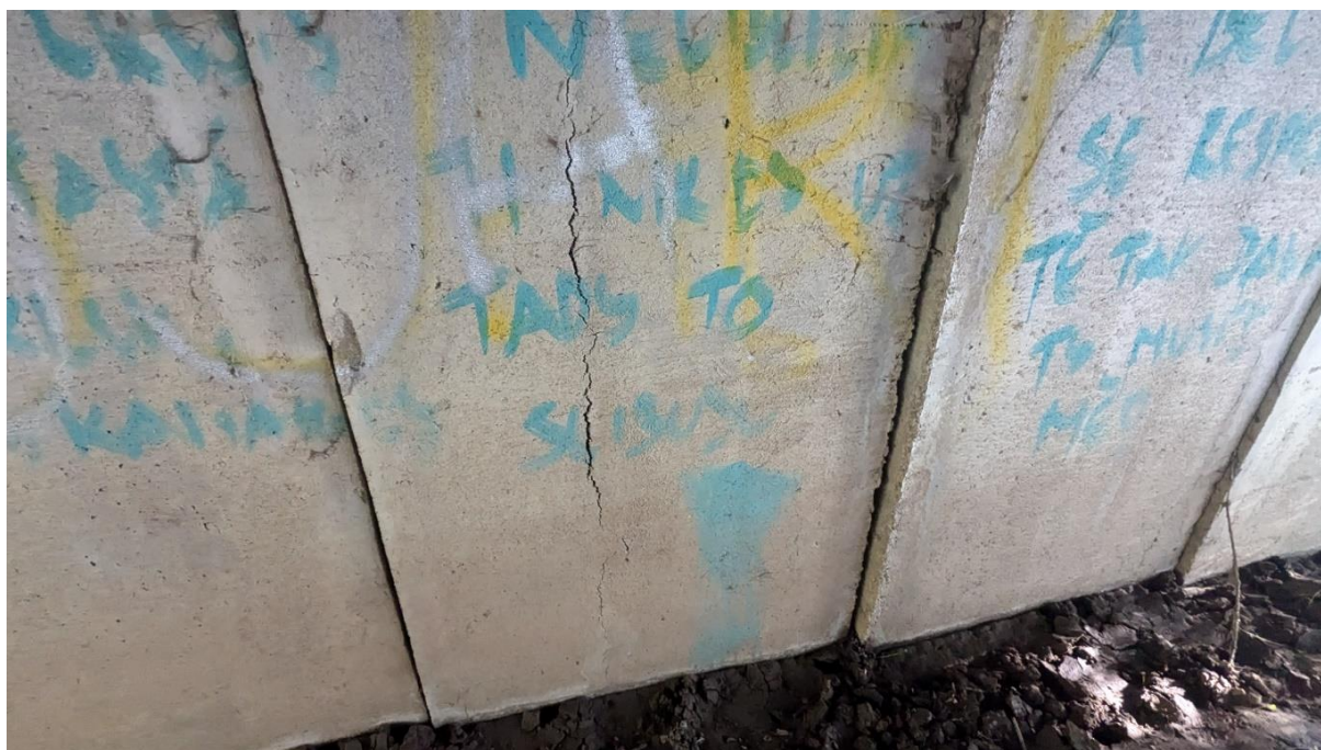
Obr. 9 Podélná trhлина ve středním poli
