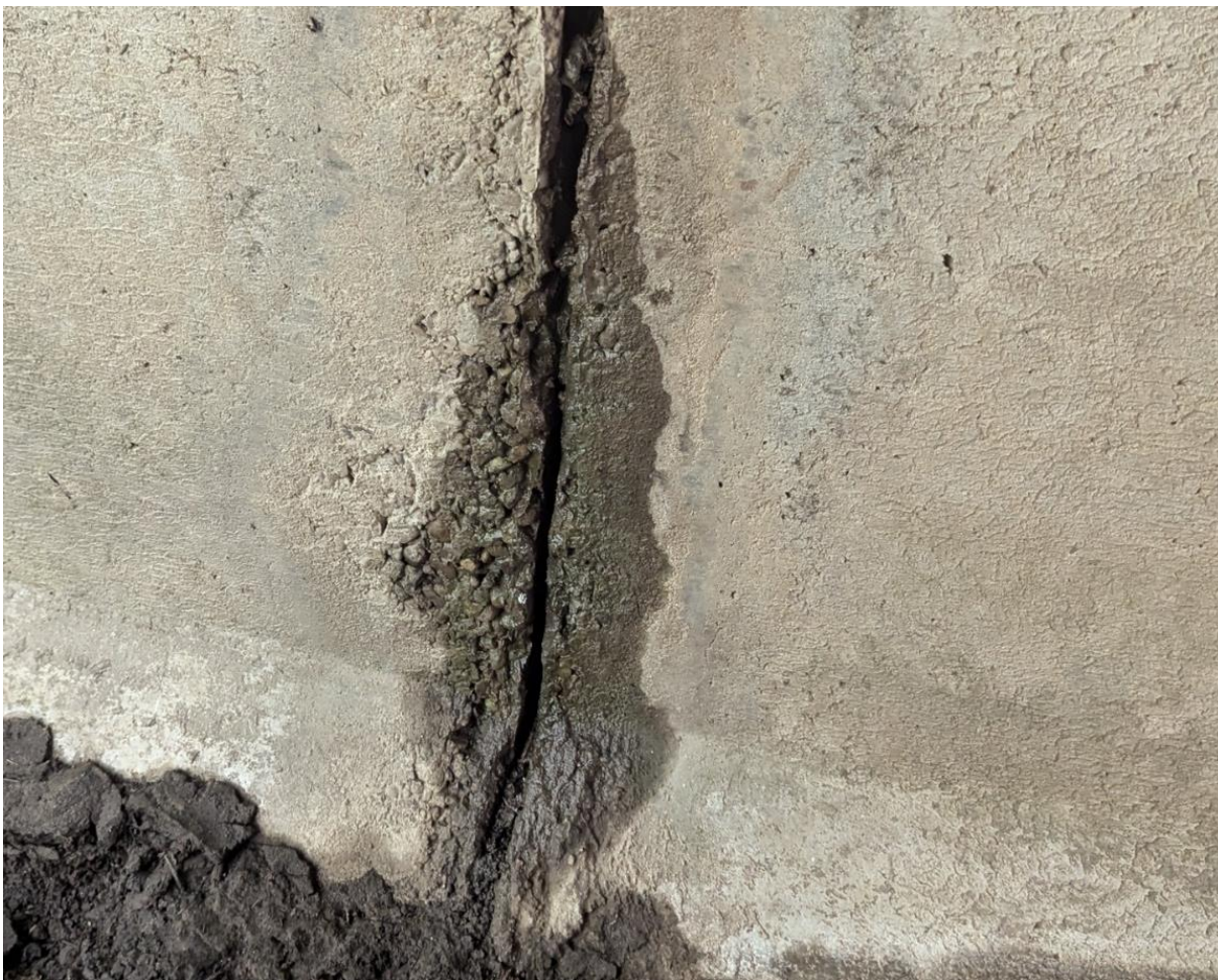
Obr. 16 Průsaky ve spojích prefabrikátů, štěrkové hnízdo
