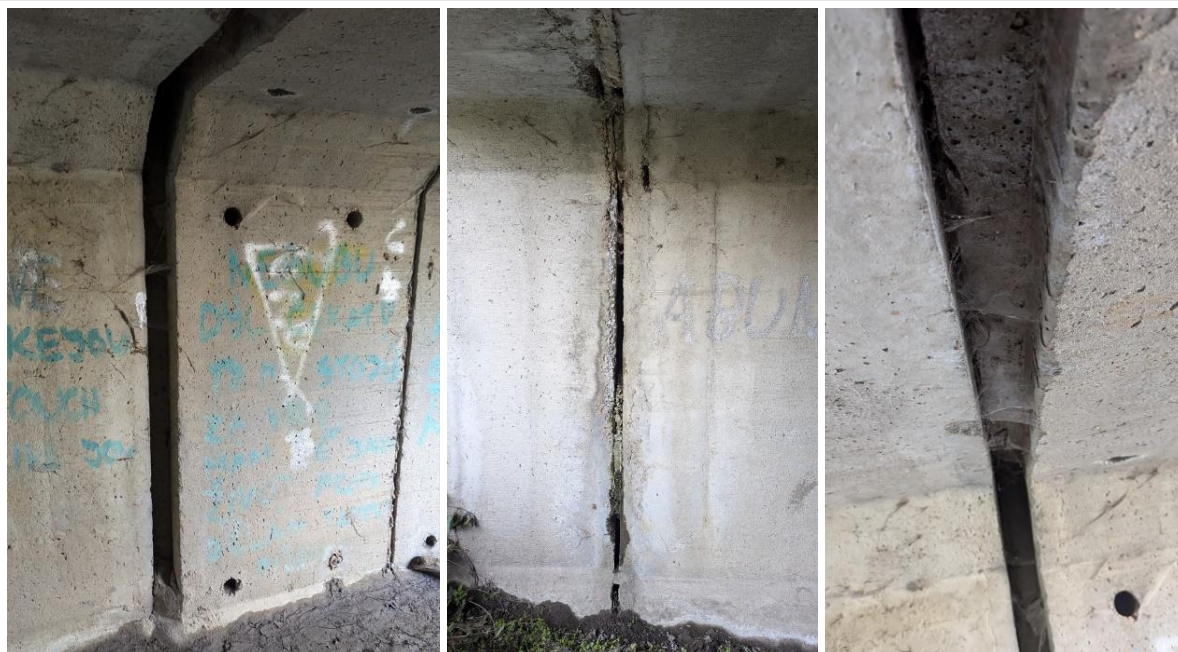
Obr. 8 Detail napojení prefabrikátů
