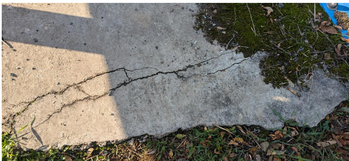
Obr. 22 Potrhaný beton na konci říms.
